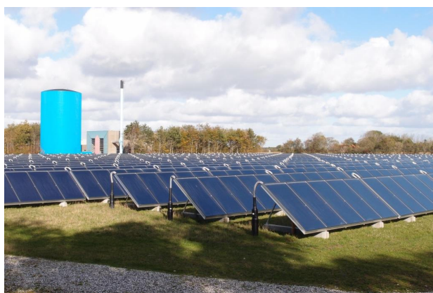
Eksempel på solfangeranlæg med teknikbygning og akkumuleringsstank (blå silo) i baggrunden.
