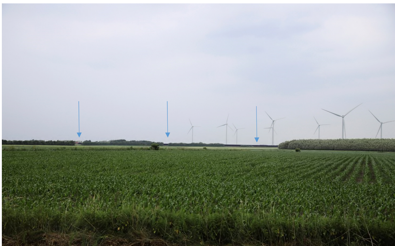
Figur 19. Visualisering af solcelleanlægget (blå pil) fra Kirkehøjvej med Vindmølleparken Holmen 1 og 2 i baggrunden. . Visualiseringen viser de visuelle forhold indtil læhegnsbeplantningen når sin fulde højde.
