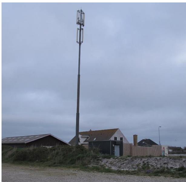
Eksisterende bolig og forretning, samt mobilmast i områdets sydvestlige hjørne nedrives.
