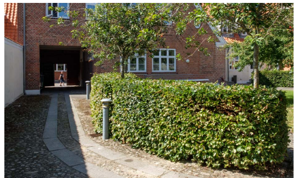
Mikkelsens Passage går gennem Bojsens Gård i Vester Strandgade. Pikstensbelægningen er suppleret med flade bordursten til en smuk helhed, der ikke kan opnås med glatte betonflader.
