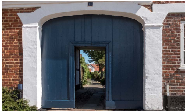
Gennem porten ved Øster Strandgade 11 får man et fint og indbydende kig til den idylliske, offentlige sti, der forbinder Øster Strandgade og Øster Allé.
