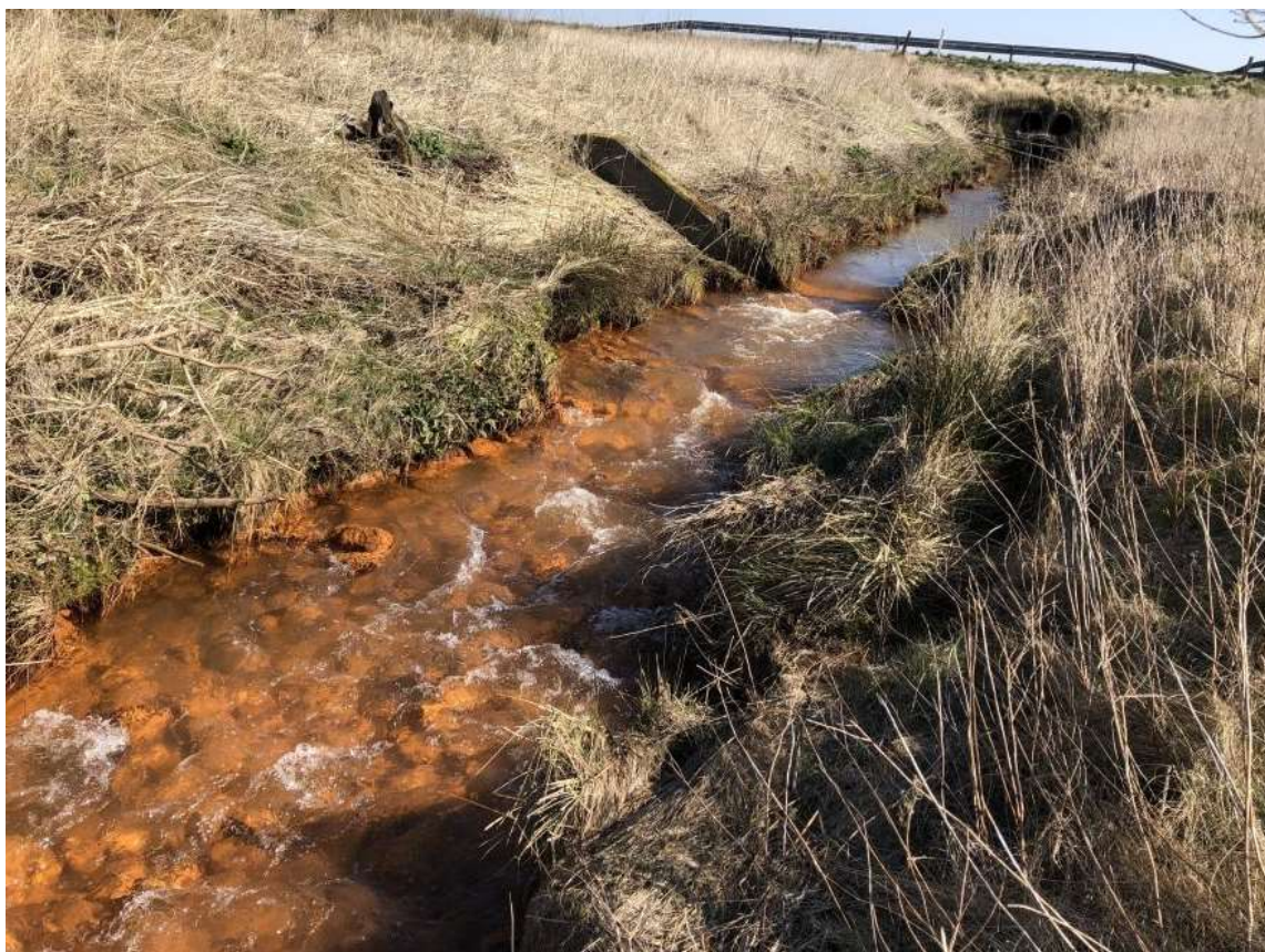
Figur nr. 14. Foto af gammelt eksisterende styrtskyggeværk ved Fasterkær Bæk (Slumstrup Møllebæk) – fotoet er set opstrøms mod Slumstrupvej – bemærk de massive okkerudfældninger på stenbunden
