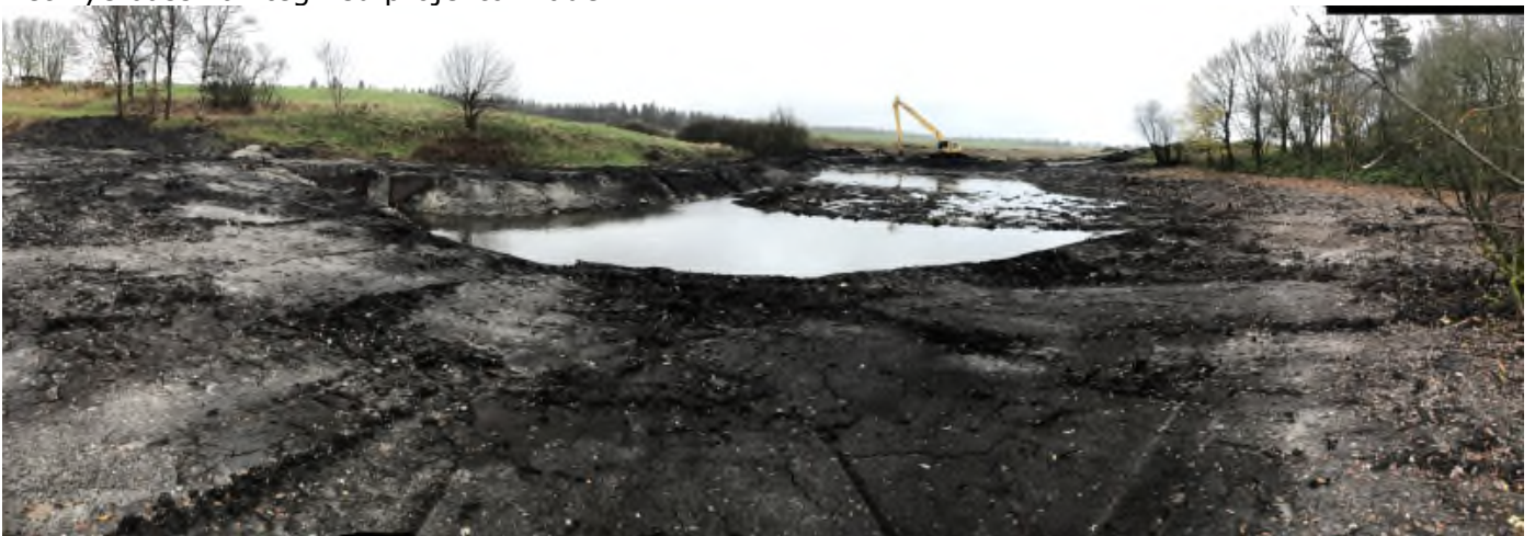
Det nye okkerrensingsbassin ved projektområde nr. 1. Set mod øst
