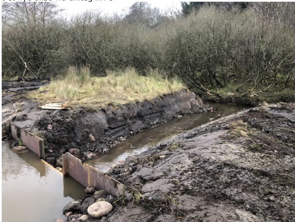
Det nye afløb fra anlæg nr. 3
