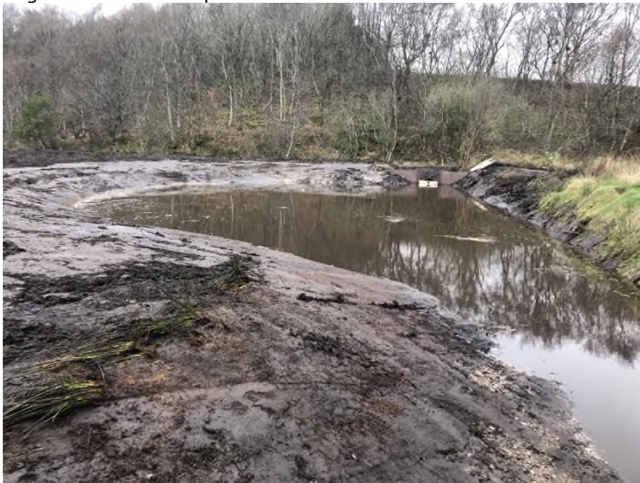
Det nye okkerrensingsbassin ved projektområde nr. 2. Set mod nord
