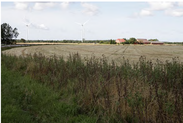
Lokalplanområdet ligger mellem de to vindmøller. Solcelleanlægget vil ikke umiddelbart være synligt fra Videbækvej grundet beplantningsbælter.
