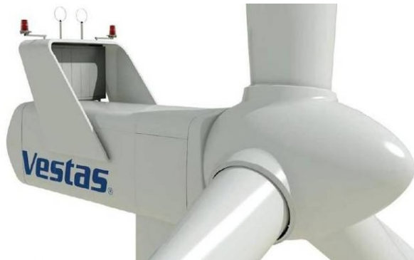
Fig. 7: Eksempel på lysafmærkning af vindmølle i overensstemmelse med kravene fra Trafikstyrelsen.
